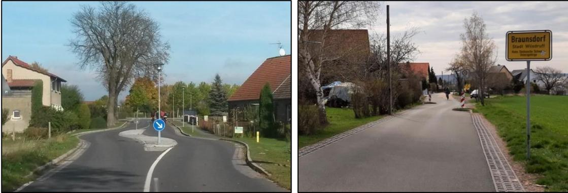
**Abb. 19** Beispiele geschwindigkeitsdämpfende Ortseingangsgestaltung
