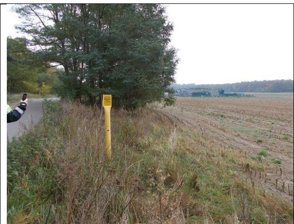
Abb.: Lichterfelder Bruch, Gasleitung
