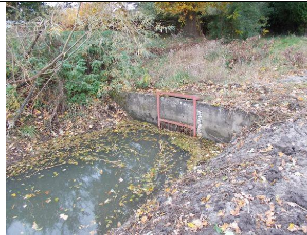
Abb. 1: Erhöhter Wasserstand im Lichterfelder Hauptgraben
