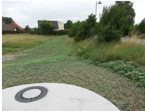
Abb. 7: Blick auf die Straßenböschung von Süd nach Nord (22.06.21)
