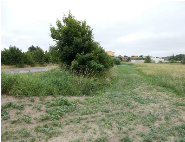
Abb. 6: Blick auf die Straßenböschung von Nord nach Süd (22.06.21)
