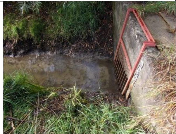
Abb. 20: Freier Abfluss am Beginn der Verrohrung
