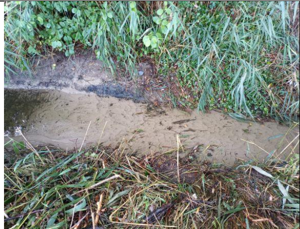
Abb. 21: Freier Abfluss am Beginn der Verrohrung
