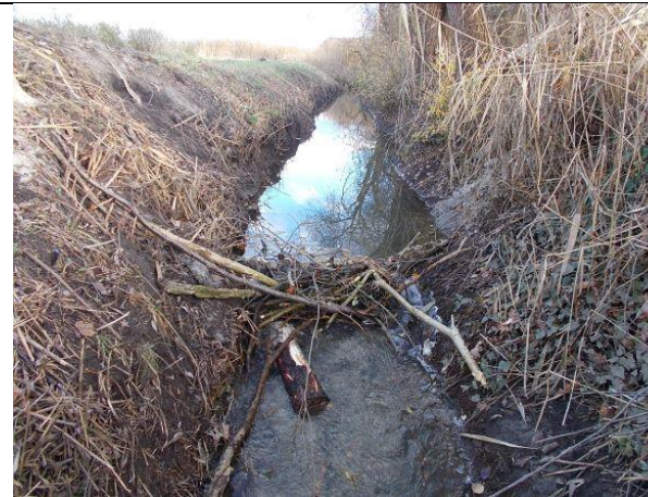
Abb. 17: Damm im mittleren Abschnitt des Lichterfelder Hauptgraben
