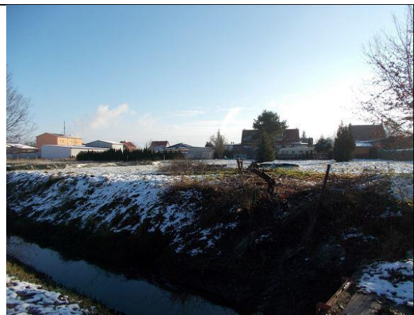
Abb. 23: Entnommene Gehölze am Rohrdurchlass
