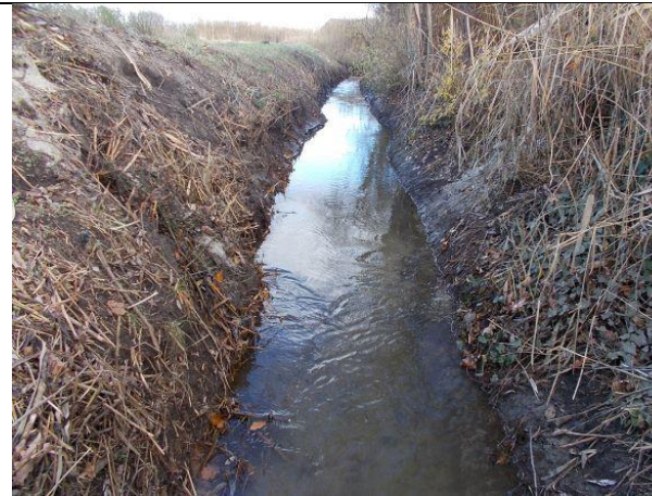
Abb. 18: Der Bereich nach Beräumung
