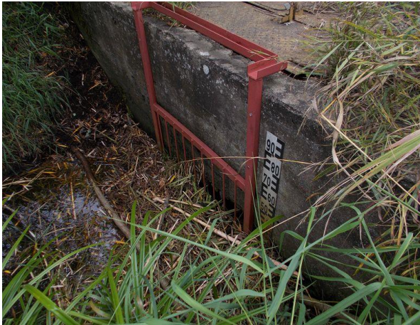
Abb. 5: Begonnener Biberstau am Einlaufbauwerk im Westen, 19.08.2021
