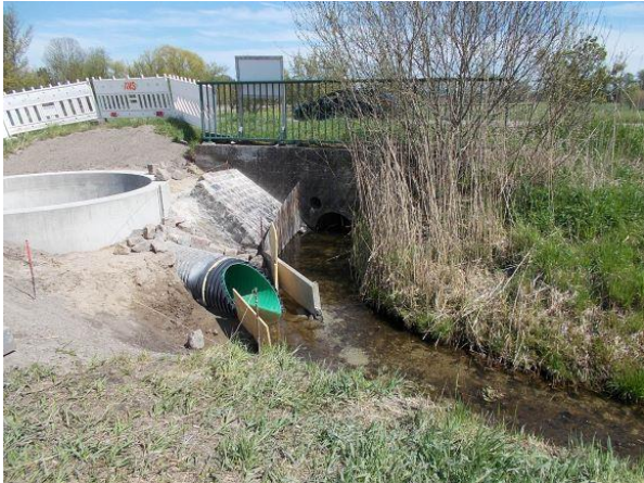
Abb. 20: Bauarbeiten im Ostteil der Fläche
