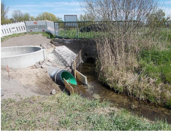
Abb. A20: Neue Regenentwässerung Eberswalder Str. in den Hauptgraben, 10.5.2021
