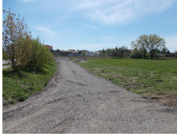
Abb. A21: Baustraßenzufahrt zur neuen Regenentwässerung Eberswalder Str., 10.5.2021
