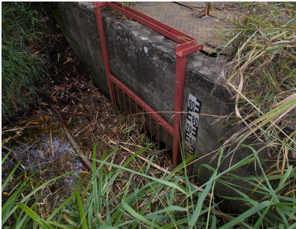
Abb. A30: Begonnener Biberstau am Einlaufbauwerk im Westen, 19.08.2021
