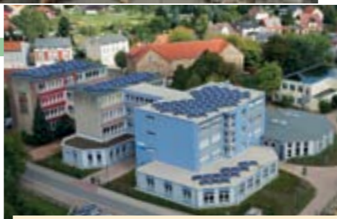
Fertigstellung des Schulerweiterungsbaus in Finowfurt, Februar 2012
