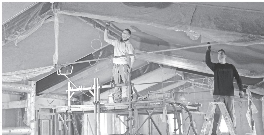
Die Verputzarbeiten im Obergeschoss sind abgeschlossen. Die Heizung für den Versammlungsraum befindet sich in den Decken. Hierzu wurden spezielle Lehmheizplatten eingebaut.
