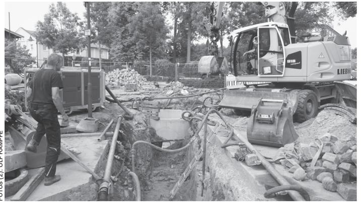
**Auch in der Hauptstraße wurde eine Betonkonstruktion an das Netz der Regenentwässerung angeschlossen.**
