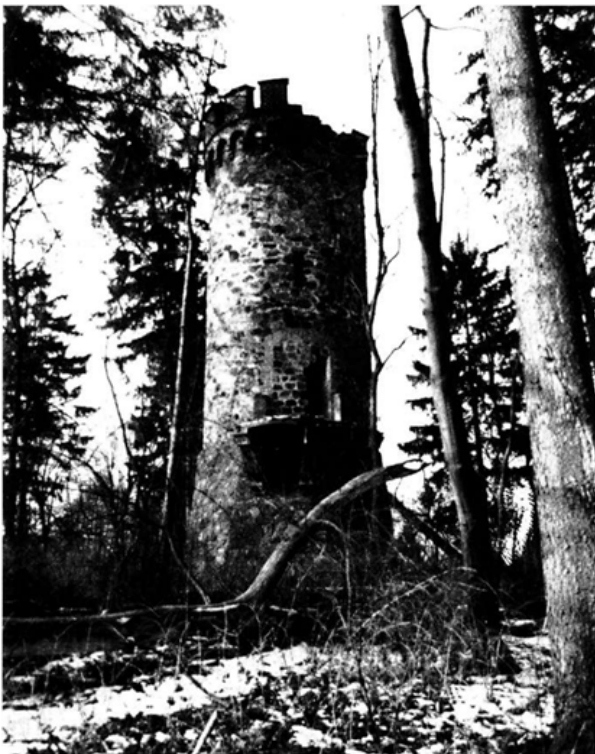
Der Askanierturm nach einem Windbruch am 13.11.1972 und im Sommer 2010
