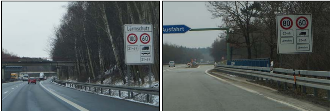
Abb. 25 Geschwindigkeitsbegrenzungen (A 10 Hohen Neuendorf / A 995 Unterhaching)
