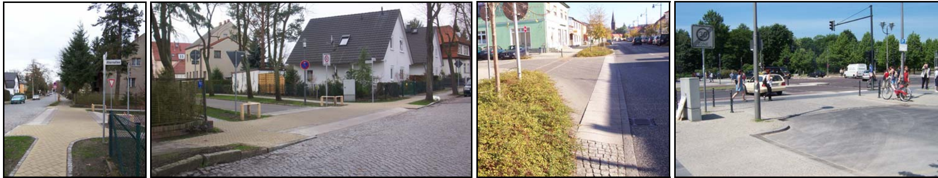
Abb. 1: Gestaltungsbeispiele Gehwegüberfahrten bzw. -aufpflasterung (Erkner, Eberswalde, Berlin)
