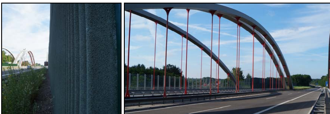
Abb. 12 verlängerte Schallschutzwand im Zuge der BAB 11
