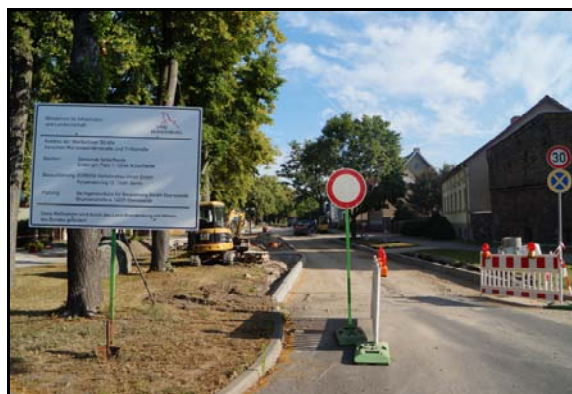
Abb. 11 Ausbau Werbelliner Straße in der Ortslage Finowfurt
