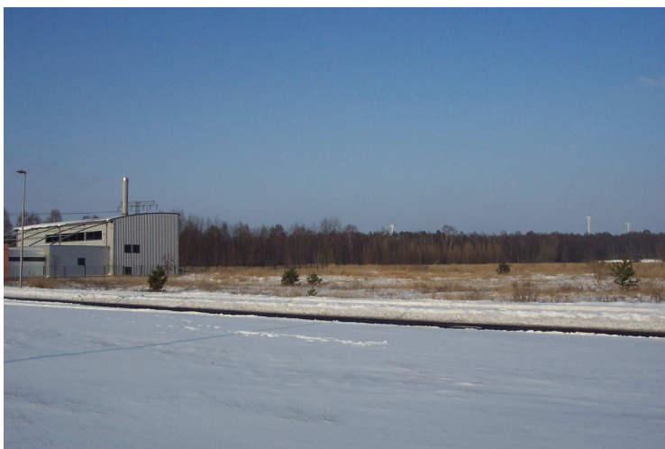
Abbildung 8: Blick zur Ersatzfläche für Maßnahmen zum Schutz, zur Pflege und zur Entwicklung von Boden, Natur und Landschaft mit einer Pflanzbindung (Konrad-Zuse-Straße)
