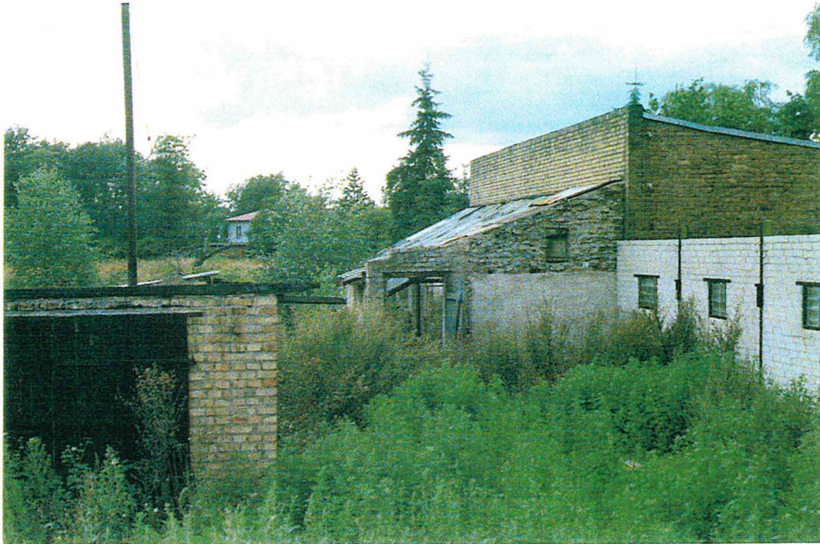
Bebauungsreste und lückige Krautschicht von Nordost. Im Hintergrund der Waldhorst an der Westgrenze.
