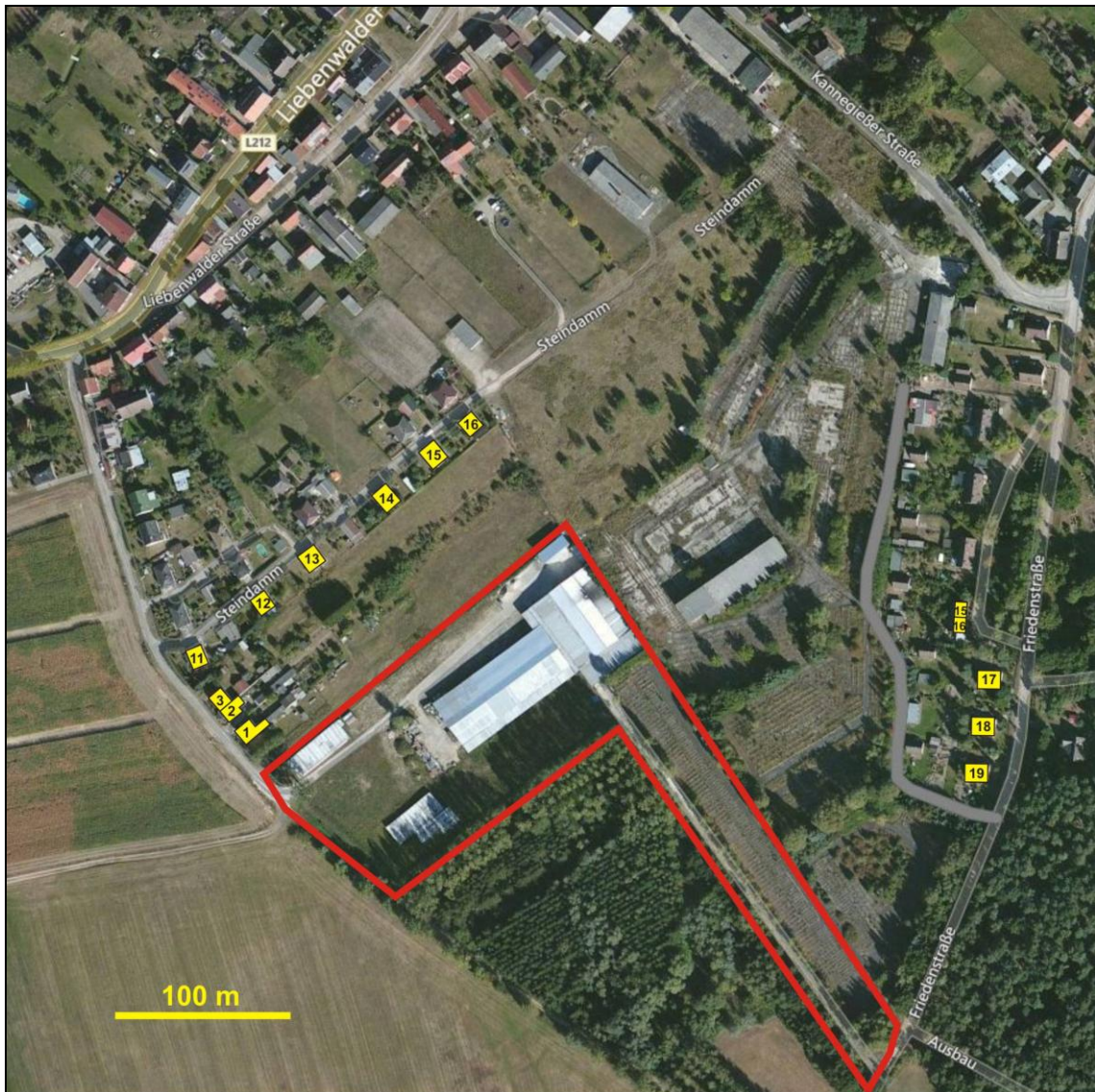
Abb. 1 Luftbildaufnahme des südwestlichen Teils der Ortschaft Groß Schönebeck mit dem Betriebsgelände des Transportunternehmens innerhalb des B-Plangebietes (rot umrandet) und den nächstgelegenen Wohnhäusern (gelb)
