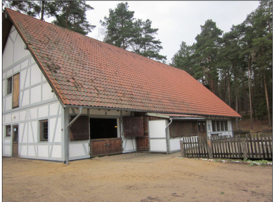
Foto 1: Gebäude im SO-Besucherzentrum
