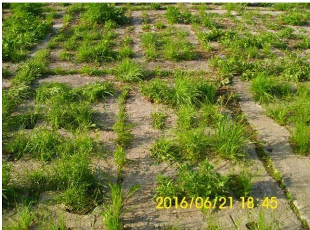
Abb. 4: Betonelemente mit Öffnungen, um Lokschuppen 1-3
