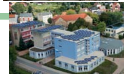
Fertigstellung des Schulerweiterungsbaus in Finowfurt, Februar 2012
