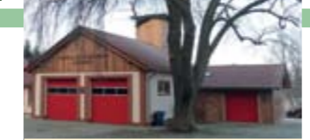
die Altenhofer Feuerwehr zieht in ihr neues Gebäude ein, Mai 2009
