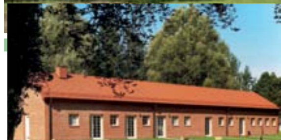
die neu gebaute Remise auf dem Schlossgelände in Groß Schönebeck wird als Touristinformation mit eigener Ausstellungsfläche eröffnet, Juni 2011
