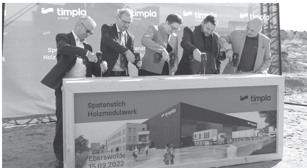
Ein Spatenstich ohne Spaten, dafür mit Akkuschauber. Bundesbauministerin Klara Geywitz, Eberswaldes Bürgermeister Götz Herrmann und Firmenvertreter gaben den Startschuss für den Bau des größten Holzmodulwerkes Deutschlands im TGE-Gewerbepark.
