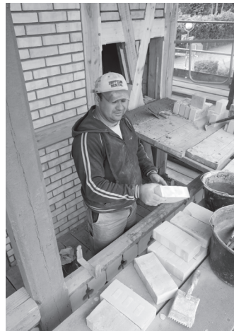
Die letzten Steine für die Fachwerkfassade wurden am 1. September 2022 gesetzt.
