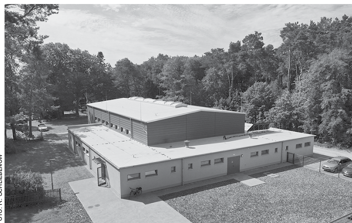
Blick von oben auf das neue Turnhallengebäude. An der Krumbachstraße gegenüber soll im nächsten Jahr noch eine Lauf- und Weitsprunganlage entstehen.
