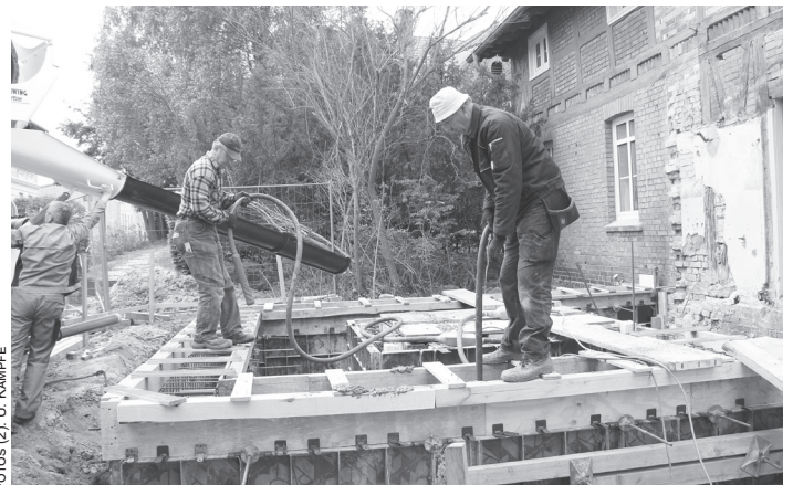
Beton für Finowfurt. Das Fundament des Fahrstuhlanbaus für das Dorfgemeinschaftshaus wird gesetzt.
