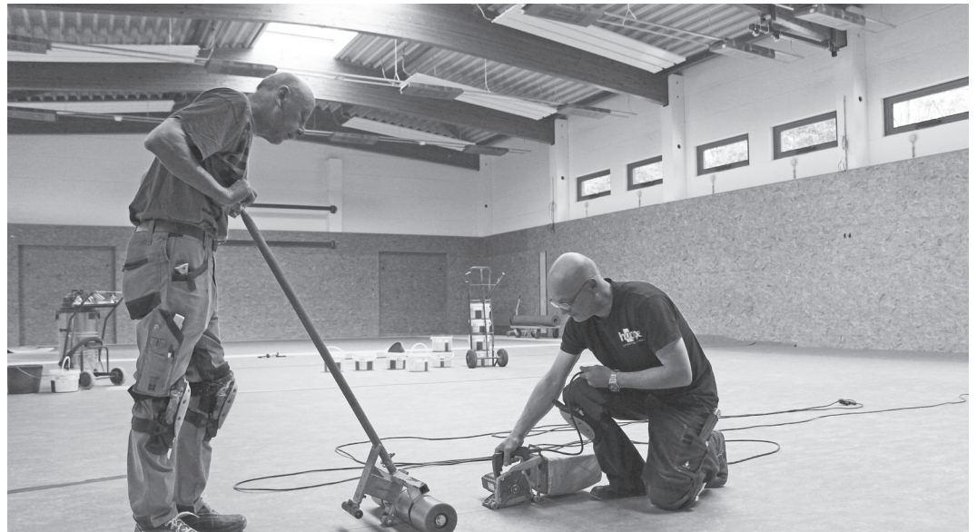
Millimeterarbeit. Torsten Schmidt und Jochen Schlott von der Firma Hoppe Sportboden GmbH aus Nossen verlegen den Fußboden in der neuen Groß Schönebecker Sporthalle.
